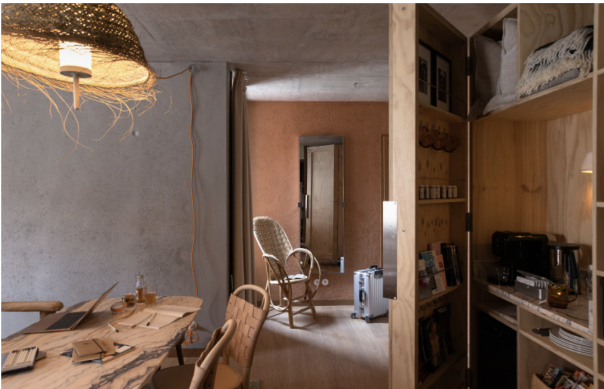
Sur les murs, un enduit d'argile granuleux remplace la traditionnelle peinture. A droite de l'image : le bar fait sur-mesure.
